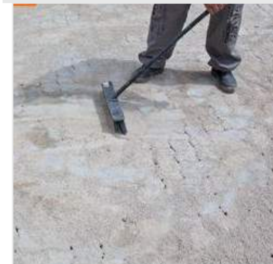
Espalhamento e varrição de pedrisco fino limpo para o rejuntamento das peças
