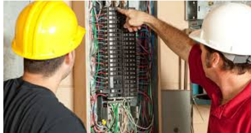
Exemplo de reparo em instalações elétricas
