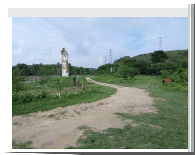
Ruínas da torre sineira
