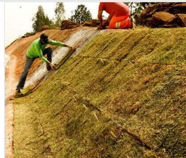
Posicionamento das gramas em placas
