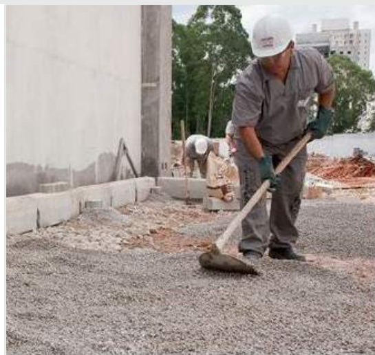
Espalhamento e nivelamento dos pedriscos para assentamento
