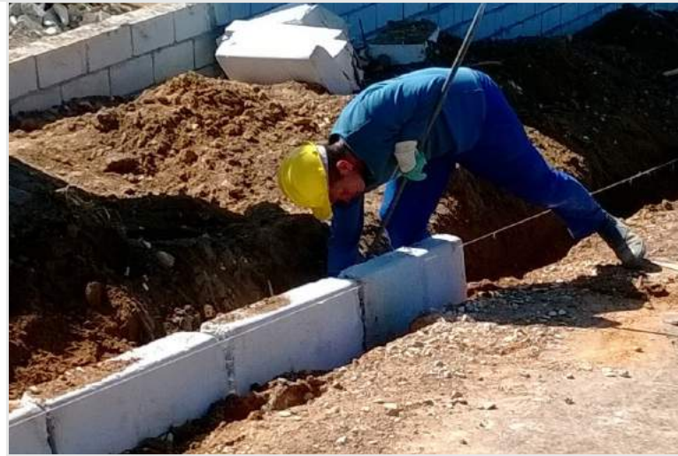
Posicionamento do meio fio
