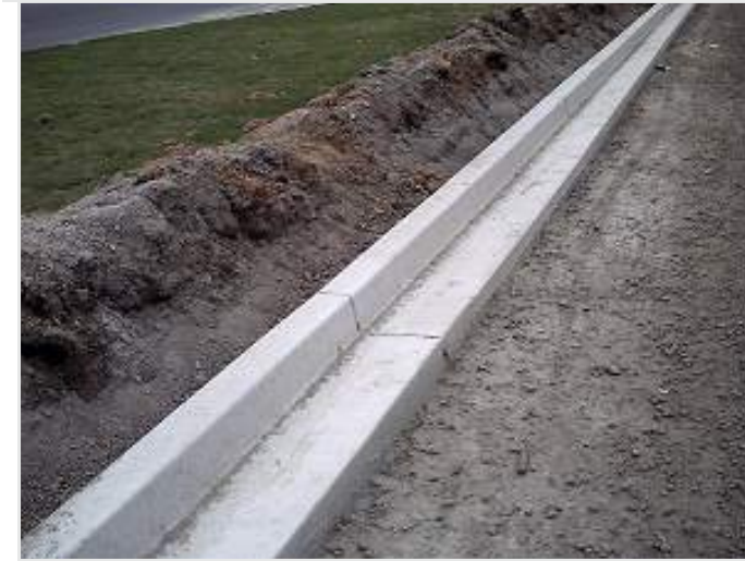
Posicionamento da sarjeta
