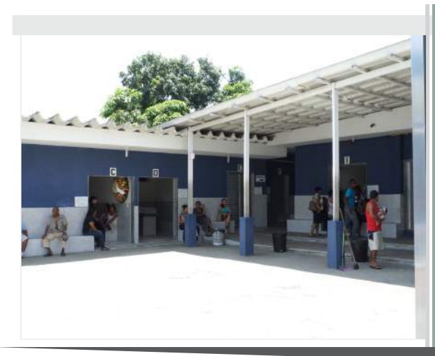
Edificações dos velórios
