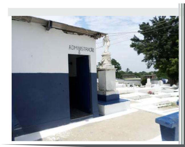
Edificação que abriga a administração
