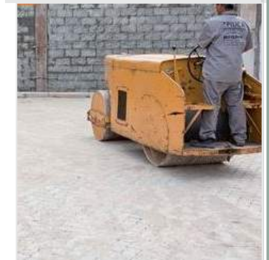
Compactação e adensamento do pavimento com placa vibratória
